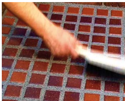
Krok 15 Po cca 20 minutách po aplikaci plochu ometeme vhodně hrubým koštětem. Tím odstraníme volně přebývající zbytky spárovací malty a utvoříme zároveň konečnou podobu spár.
