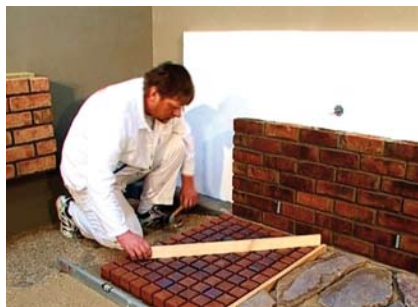
Krok 3 Položenou dlažbu nutno v dílčích plochách srovnat pomocí latě.
