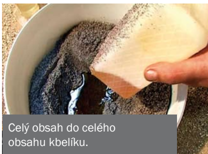
Krok 6 Jedná se o dvousložkovou speciální maltu. Nejprve smícháme sypké množství materiálu s epoxidovým tvrdidlem.
