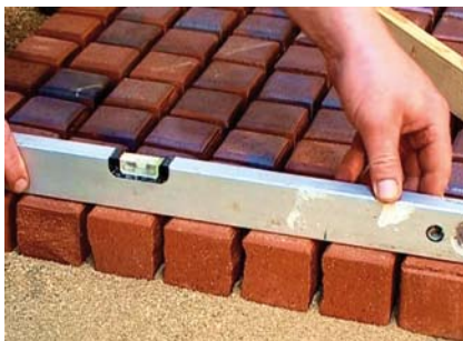
Krok 4 Jako poslední kontrola před spárováním je ověření rovinnosti pomocí vodováhy, nebo požadovaného spádu.
