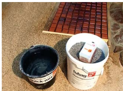
Krok 5 Spárování dlažeb provedeme materiálem quick-mix spárovací malta na dlažbu PFM vodopropustná.
