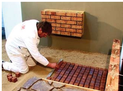
Krok 1* Dlažbu pokládáme do malty NVL 300 . Lepíme pomocí materiálu RKS a F-DBK .
