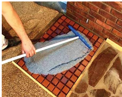
Krok 13 Dbáme na to, aby malta byla důkladně zapracována do všech spár v celém průřezu.
