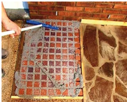
Krok 14 Při stanovení množství potřebného pro spotřebu na danou plochu musíme být přesní, neboť jakékoli zbytky již nejsou dále použitelné.
