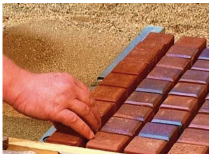
Krok 2* Pokládané prvky dlažby klademe dle předem rozvrženého vzoru a dodržujeme stejné spáry.
