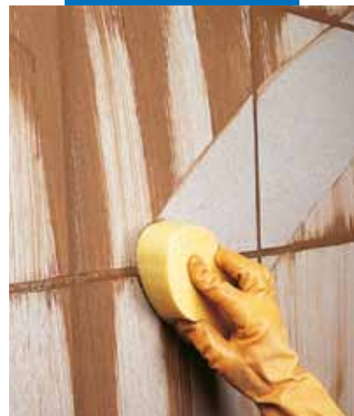
Dokončení povrchu obkladu houbou
