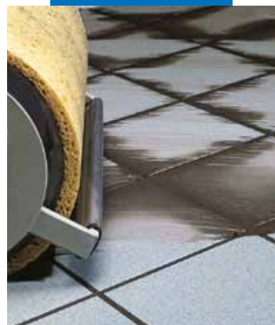
Strojní dokončování povrchu dlažby
