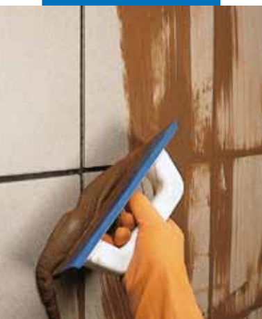
Spárování obkladu v exteriéru gumovou stěrkou
