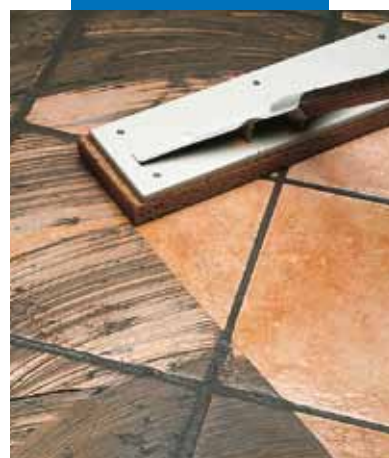
Čištění jedenkrát pálené dlažby houbovým hladítkem
